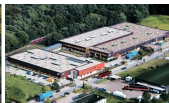
Technique de fabrication NORD Gadebusch
